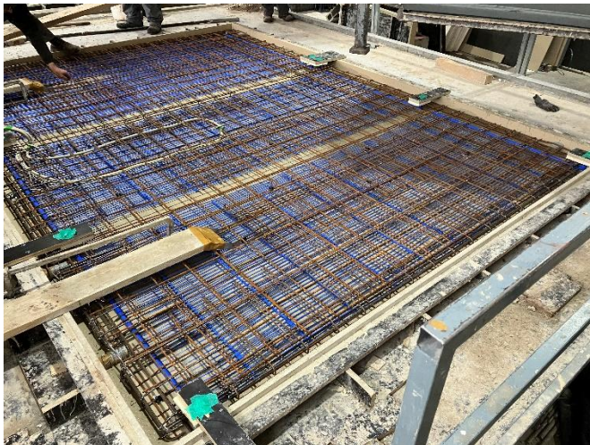
Bild: Schalung Betonelement mit der bereits eingelegten Bewehrung und den Kapillarrohrrmatten (Quelle: Fraunhofer- IBP)
