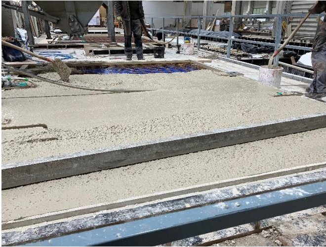
Bild: Gießvorgang des SolarVHF-Betonelementes, Quelle Fraunhofer IBP
