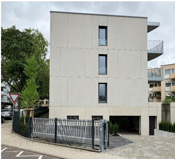
Bild: Fertige Ostfassade mit SolarVHF-Elementen, Quelle Fraunhofer IBP
