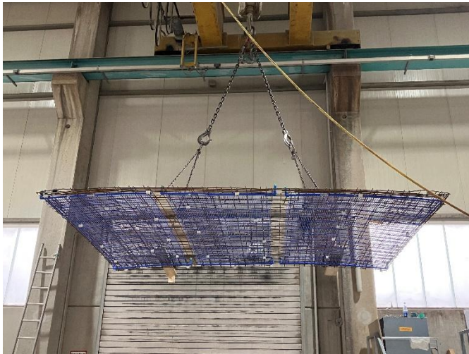
Bild: Kapillarrohrrmatte an Bewehrung befestigt, vor dem Einheben in die Schalung (Quelle: Fraunhofer IBP)
