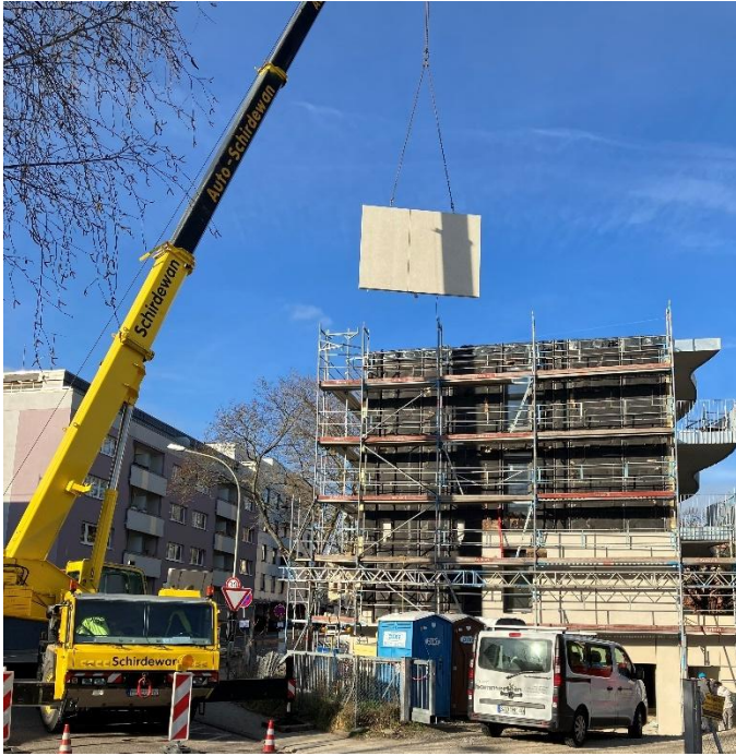
Bild: Montage der SolarVHF-Elemente an der Ostfassade, Quelle Fraunhofer IBP
