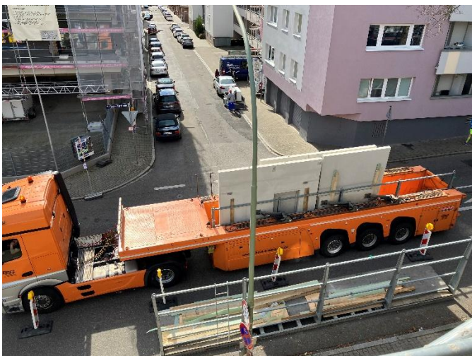
Bild: Anlieferung der Betonfertigteile mittels eines Flatliner-LKW, Quelle Fraunhofer IBP
